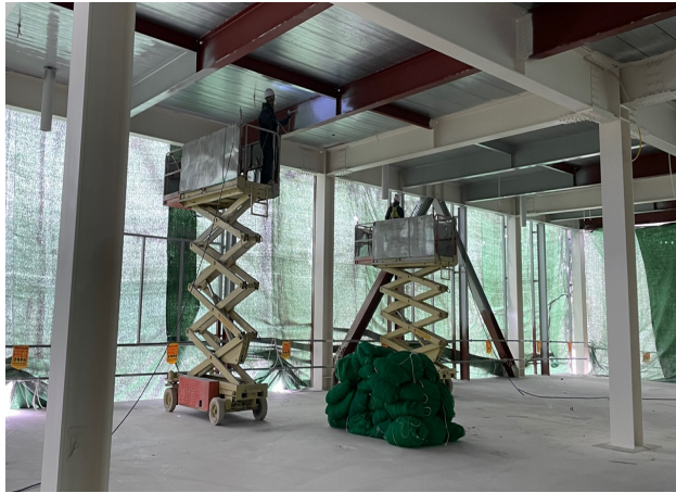
원이앤씨는 철저한 완벽시공으로 주어진 과업에 좀 더 고민하고 정성을 들여 가치를 높이는 시공, 건물 유지관리를 고려한 창의적인 시공으로 경쟁력을 높일 수 있었다
